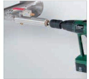
CS delme tertibatı ile basınç altında delme
