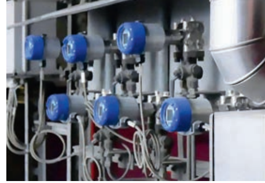
Bir enerji santralinde OPTIBAR DP 7060 fark basınç transmitterleri
