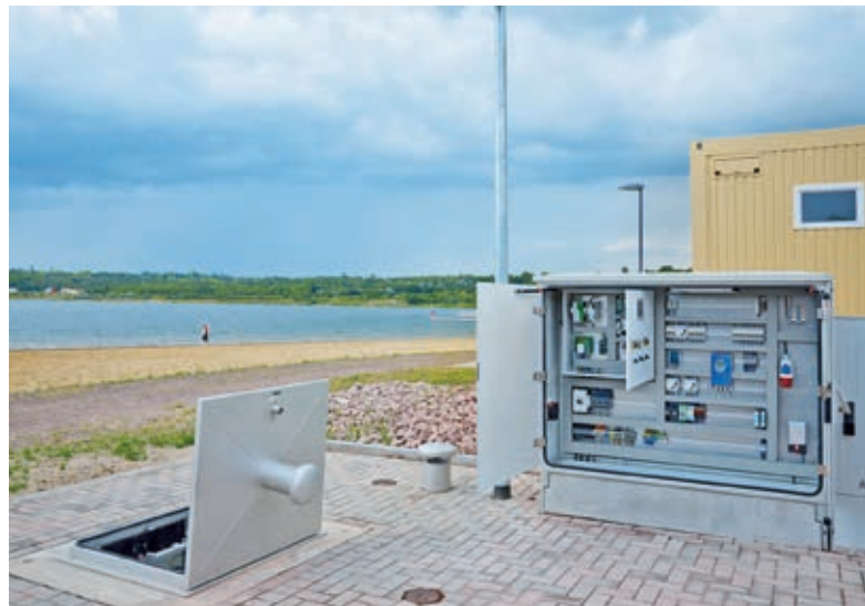
Uzaktan veri iletişimi ile dezenfektan ölçümü
