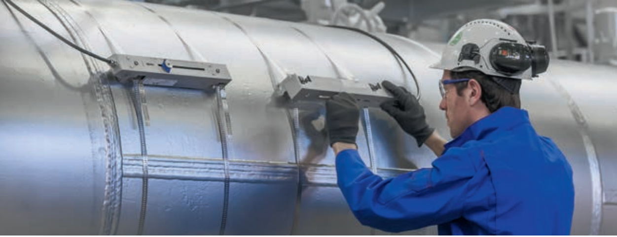
Büyük hat çaplarında kelepçeli akış ölçümü
