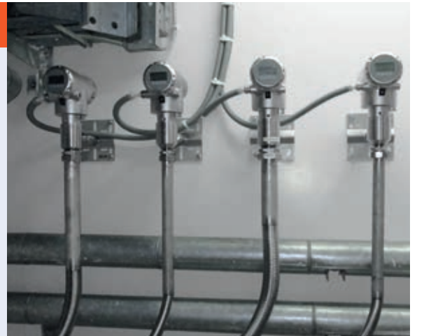
Işınlanmış ortamda kondensatların TDR seviyesi ölçümü
