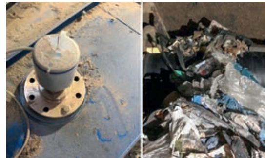
Bir atık arıtma tesisinde plastik atıkların seviye ölçümü
