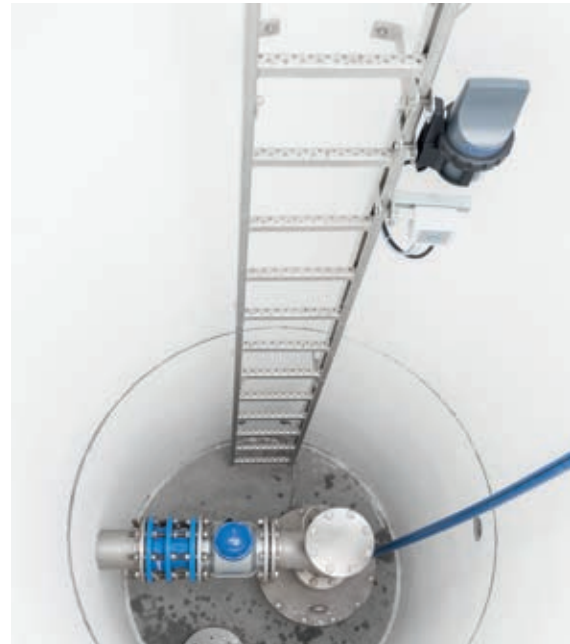
GSM/GPRS haberleşmeli pille çalışan IP68 ölçüm noktası
