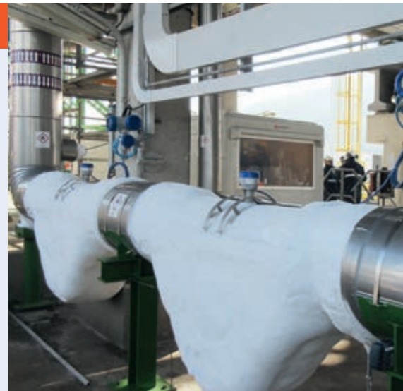
Çift yönlü bir doğal gaz sınırı ölçüm istasyonu için custody transfer akış ölçümü
